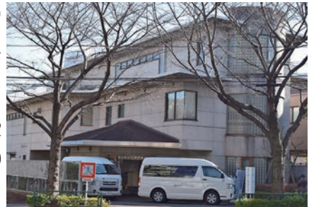
松が丘シニアプラザ全景
